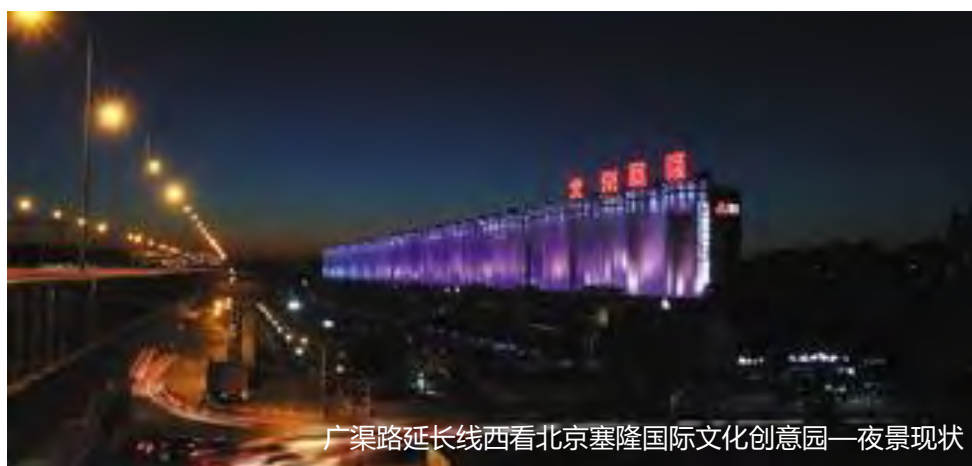
广渠路延长线西看北京塞隆国际文化创意园—夜景现状
