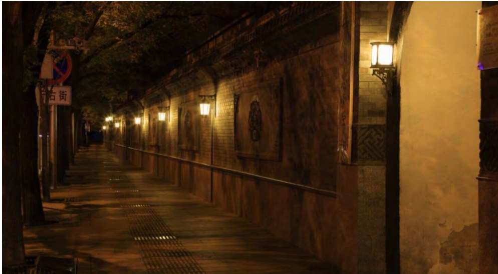
连续墙面（砖墙）
