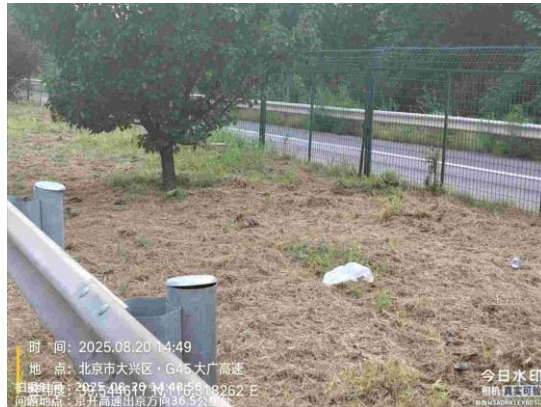
京开高速进京方向<榆垓收费站-玉泉营桥>（大兴段：20.8公里处加油站公厕纸篓满冒 T15:11）
