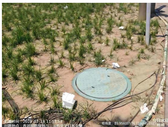
三元桥绿地（朝阳段：三元桥西侧绿地内有废弃物 T11:40）
