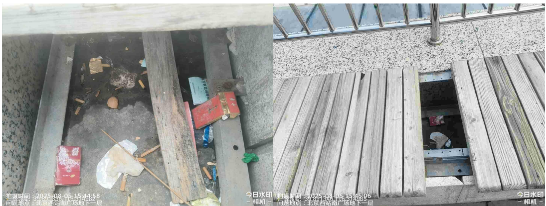
北京西站南广场出租车等候区(东侧有废弃物)T15:35
