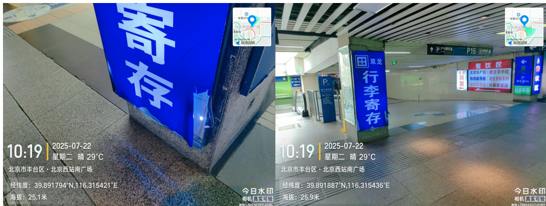
北京西站南广场 8 号扶梯(扶梯不洁、辅助设施乱放)T10:14
