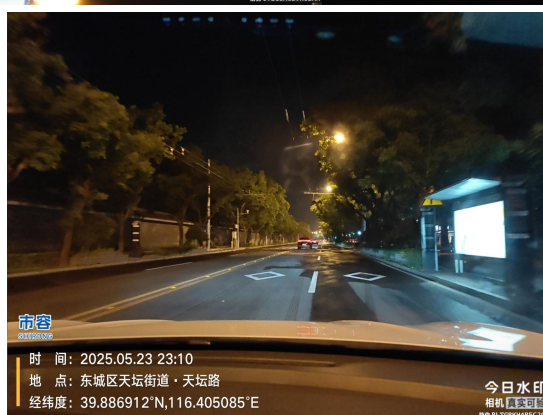
珠市口东大街(机械冲刷 26 段作业后效果良好)T23:05
