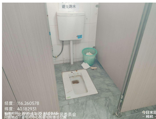
南邵镇张各庄村村委会东公厕(隔断板损坏、小便池出水器锈蚀)T11:35
