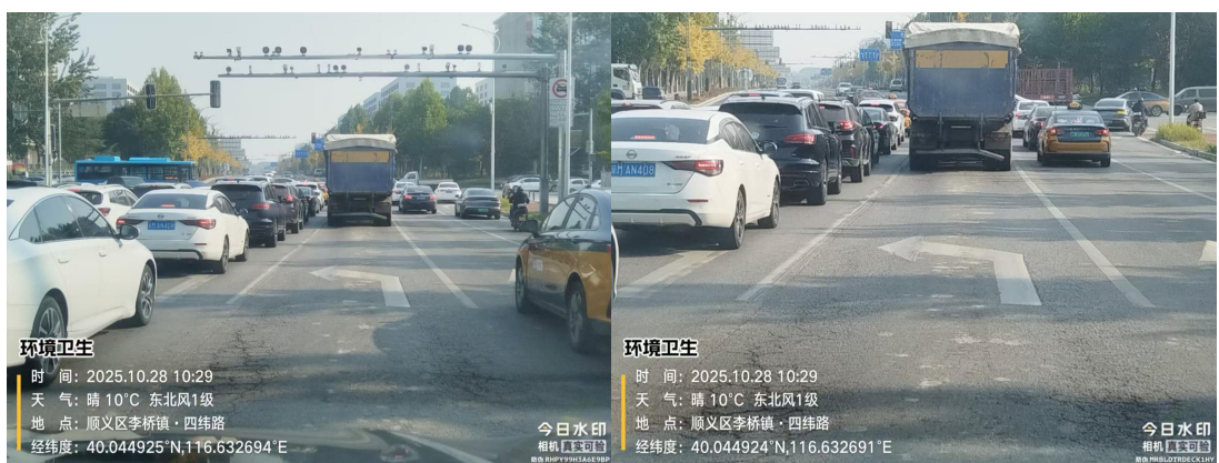
机场东路(路面有泥饼)T10:32
