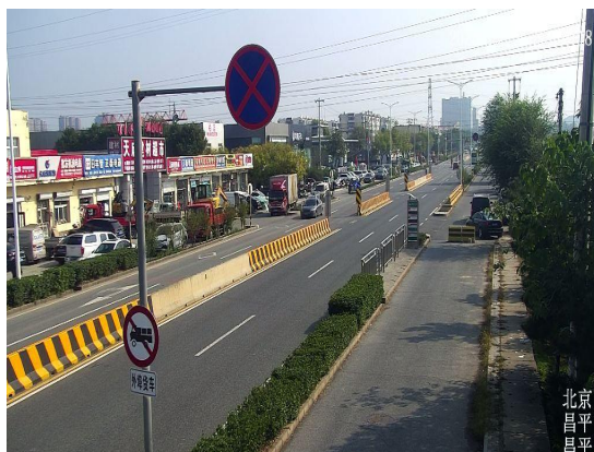
亢山路(非机动车道路边线有浮土)T10:35
