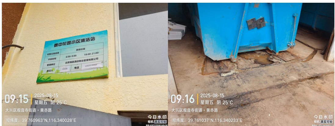
泰中花园垃圾楼(站内有异味)T09:16
