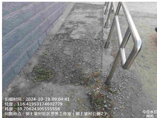
郭上坡村公厕 2(无障碍坡道破损)T09:04
