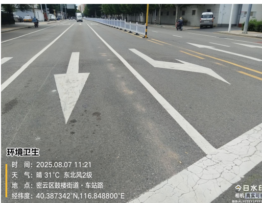
车站路(路面有浮土)T11:21
