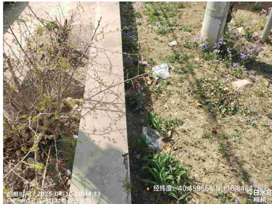
石墙沟村委会门前路(良好)T10:39
