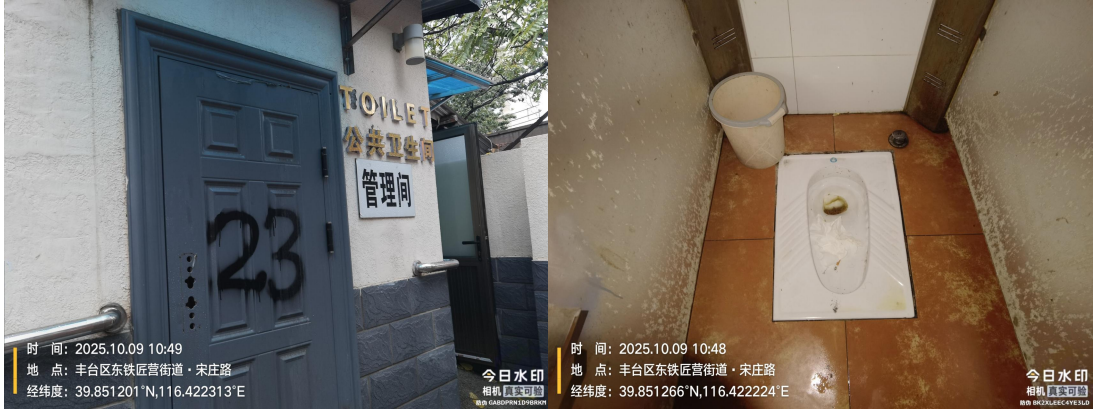
分钟寺三角地(坑位不洁、便池内有积存物)T10:57
