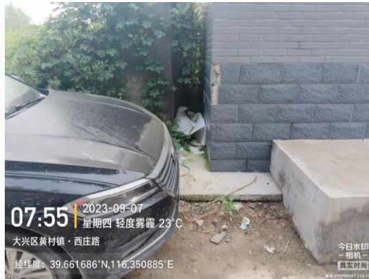
西庄村西公厕（未安装标识牌 T08:02）
