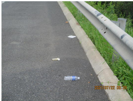
机场第二高速出京方向<平房桥-T3 航站楼> (通州段: 9.8
