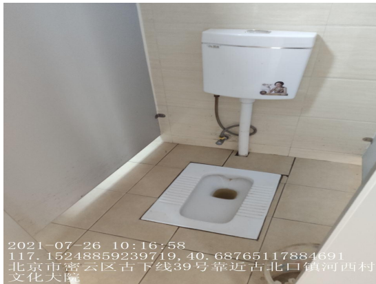
河西村甘桥南公厕（没有无障碍厕位、坡道/现场检查未见灭火器）T10:16
