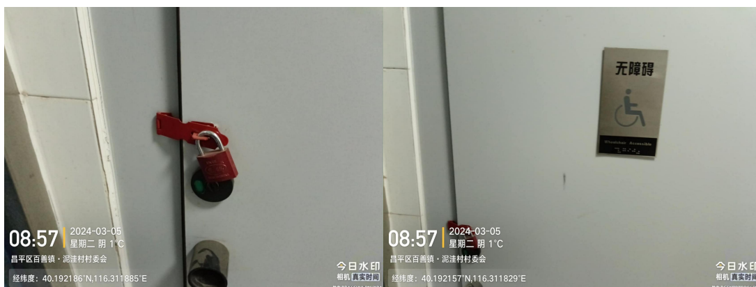
泥洼村东公厕(厕内地面有明显污渍、废弃物)T09:02
